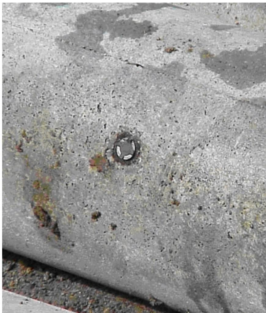
**Figura 4.3 – Particolare di una valvola di iniezione di secondo tempo**
