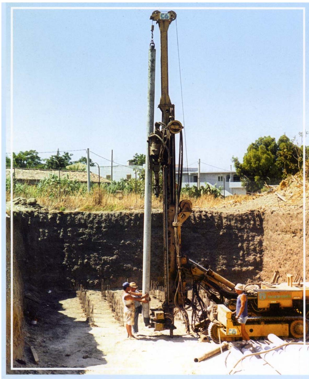
**Figura 4.5 Anas spa. SS 106 Jonica Realizzazione Svincolo Malderiti e Asta di Raccordo Aeroporto di Reggio Calabria Reggio Calabria. Installazione Micropalo Prefabbricato nelle fondazioni delle pile del Ponte “Madonna del Buon Consiglio”**
