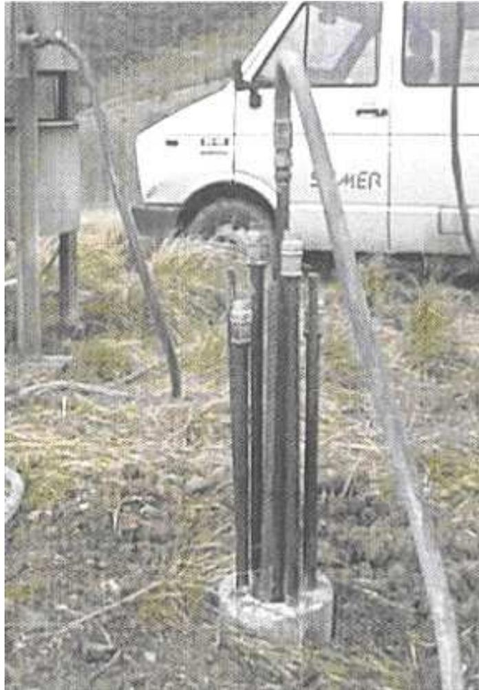
**Figura 4.3** Particolare Iniezione di primo tempo
