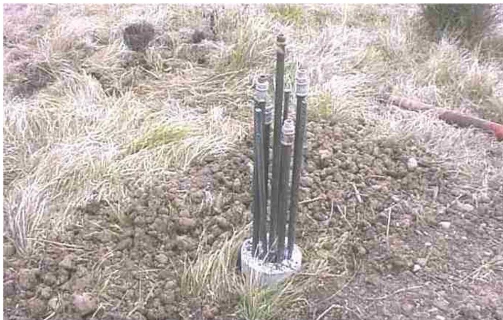
**Figura 4.4 Particolare testa micropalo con cinque tubi di iniezione**
