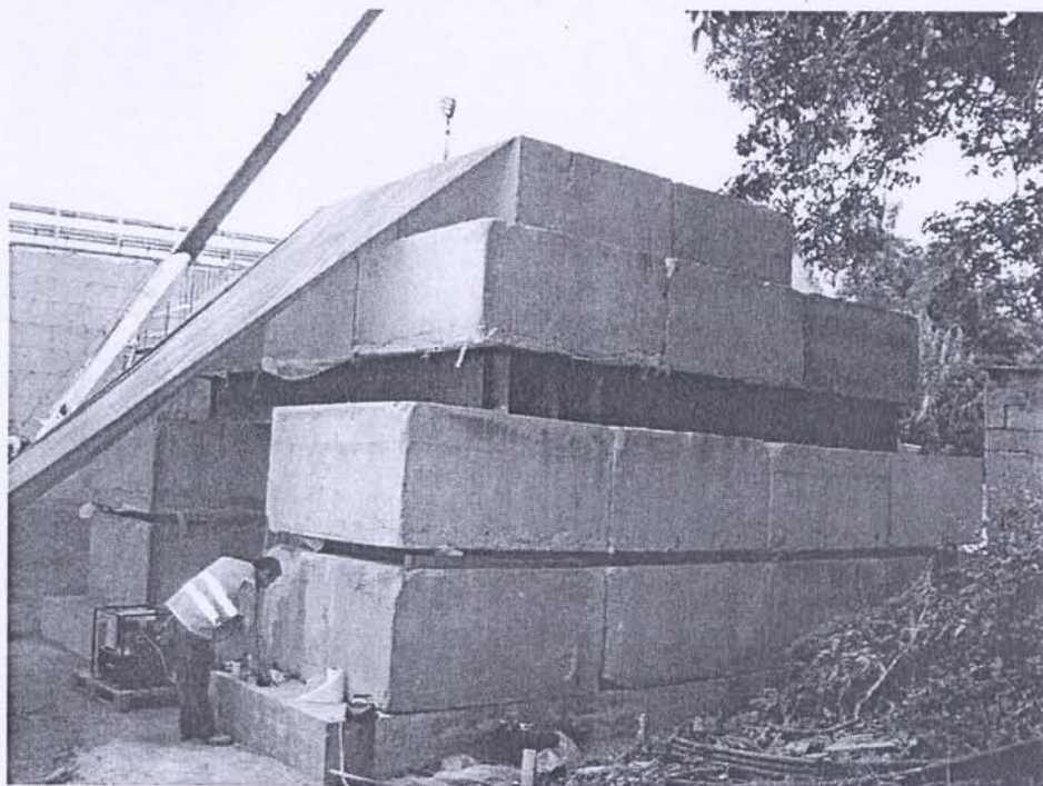
Foto 1 e 2 – Zavorra in cls e struttura di sostegno in acciaio
