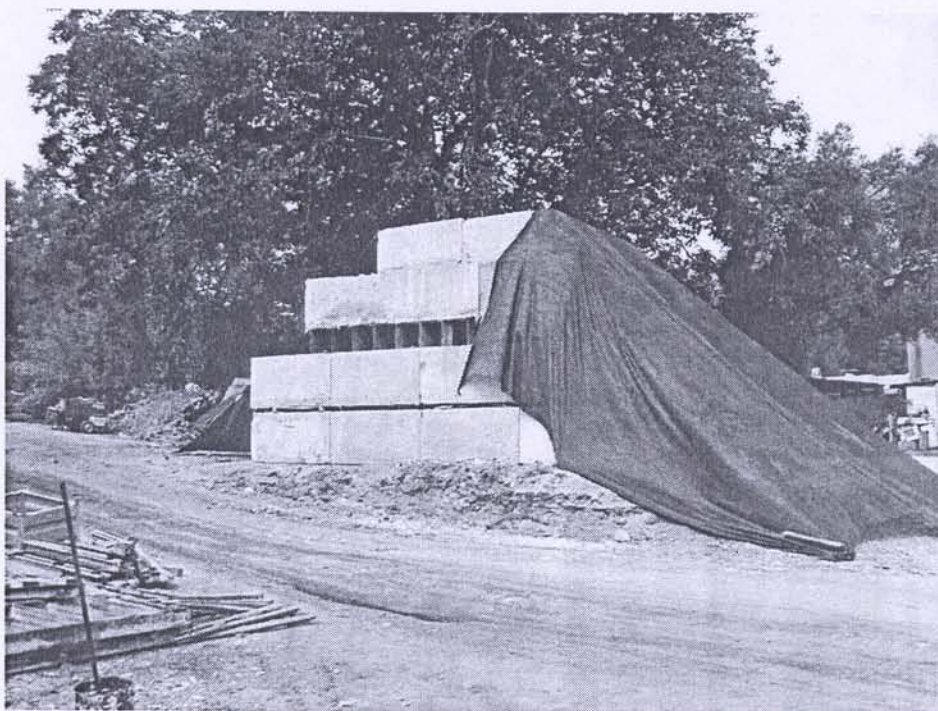
Foto 1 e 2 – Zavorra in cls e struttura di sostegno in acciaio
